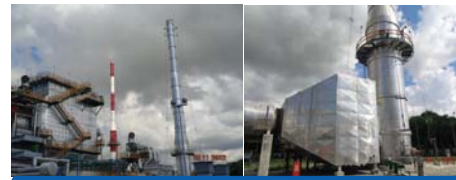
Thermal Oxidizer และระบบ SNCR ร่วมกับ Ultra-Low Emission Burner
